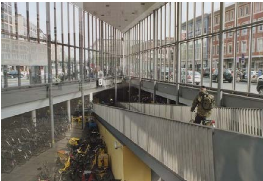
Figur 5-20 Cykelstationen i Münster i Tyskland. Ett exempel på cykelgarage där byggnaden får synas och där rampen ner i garaget medger cykling.
