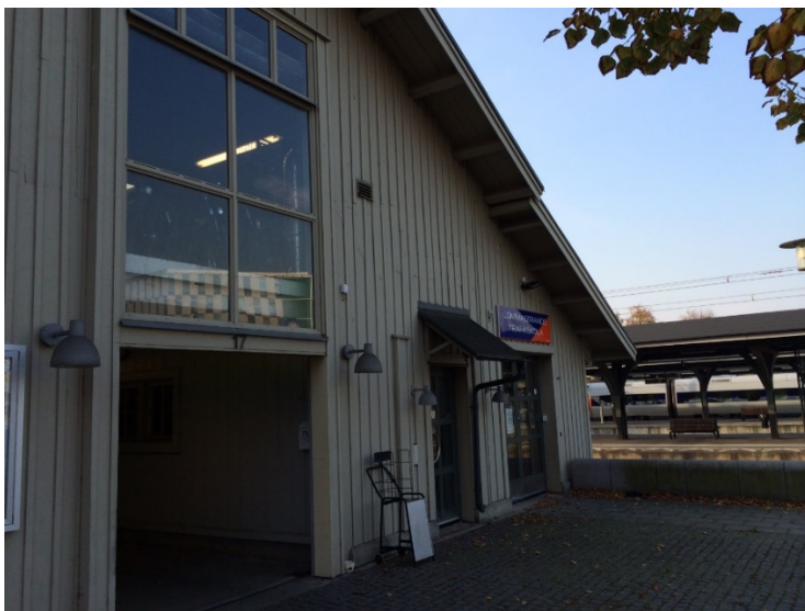
Figur 5-13 På östra sidan finns cykelgaraget Godsmagasinet och en ledränna.
