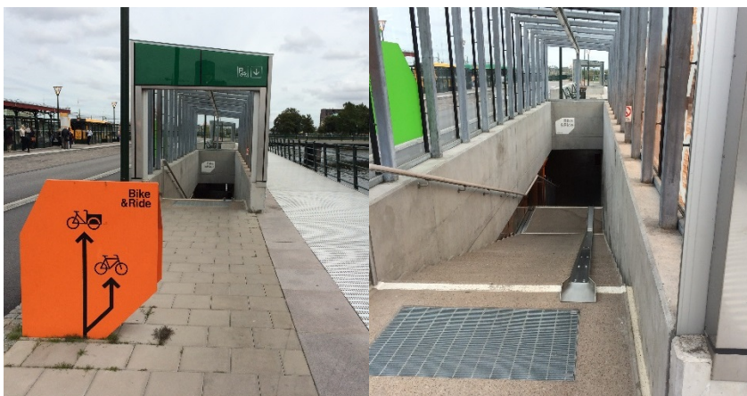
Figur 5-8 Från "centrumhållet", varifrån de flesta cyklisterna kommer, finns en trappa med ledränna ner till cykelgaraget.
